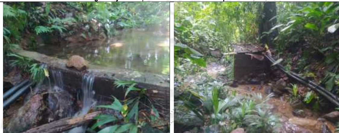
Figura 8. Tanque de abastecimiento y desarenador del predio 7.
