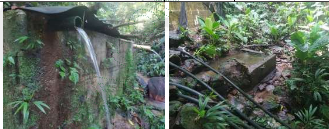
Figura 9. Tanque de abastecimiento y desarenador del predio 7.
