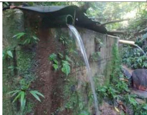
**Figura 9. Tanque de abastecimiento y desarenador del predio 7.**
