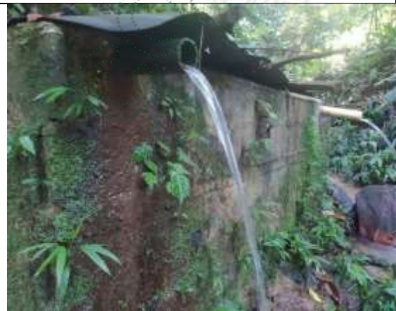
Figura 9. Tanque de abastecimiento y desarenador del predio 7.
