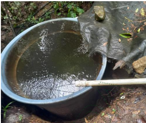
Imagen 2. Obra de control de caudal.
