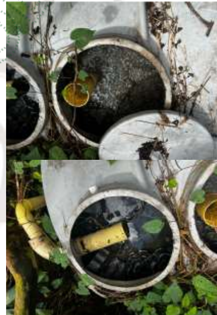
Fotos 3, 4 y 5. Tanque séptico para tratar aguas residuales domésticas de la vivienda de la Finca Piscícola La Secreta. Fuente Cornare 2024.
