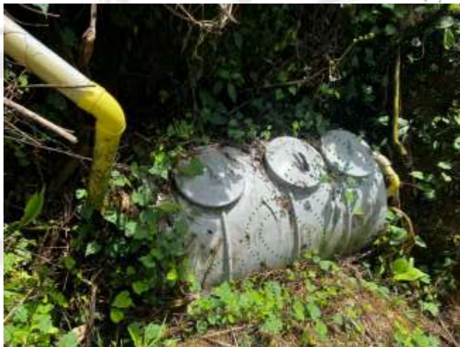
Fotos 3, 4 y 5. Tanque séptico para tratar aguas residuales domésticas de la vivienda de la Finca Piscícola La Secreta. Fuente Cornare 2024.
