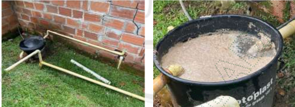
fotos 6 y 7. Unidad de pretratamiento “Trampa grasa”, del STARD. Fuente Cornare 2024
