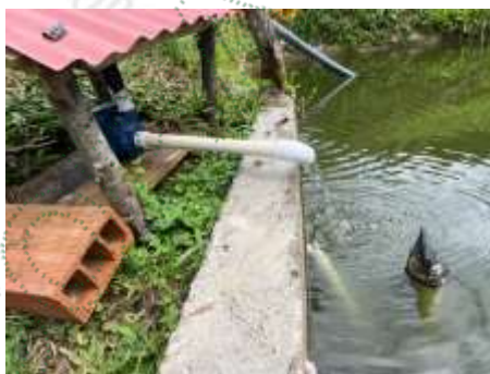
Foto 1 y 2. Motobomba usada en el proceso de recirculación de agua de los estanques piscícolas. Fuente Cornare 2024.
