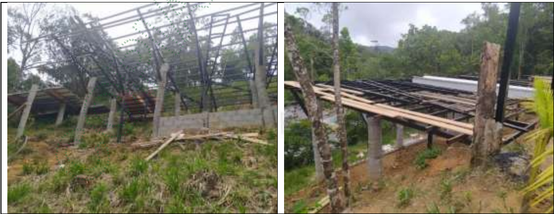
Figuras 1 y 2. Obra en construcción en el acceso al estadero El Paraíso.
