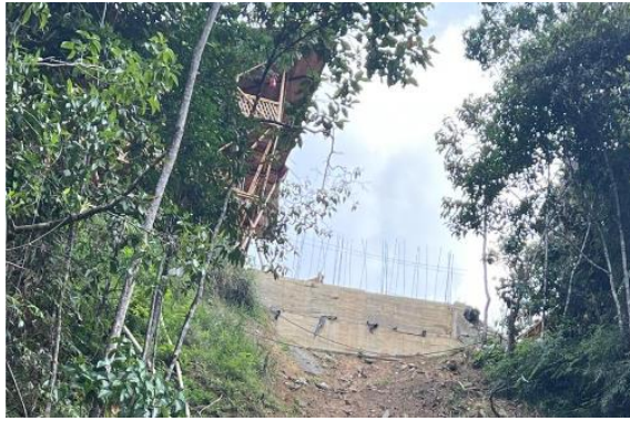
Foto 4. Muro de contención, vista tomada desde la quebrada La Alemania
