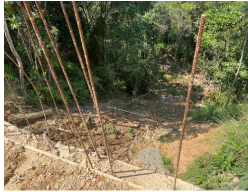
Foto 5. Muro de contención, vista tomada desde la Cabaña del señor Fredy
