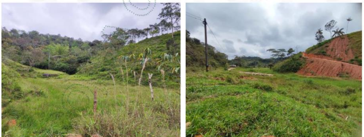
Foto 2: Zona de empozamiento e inundación de las quebradas 1 y 2. Fuente: Cornare, 2024.
