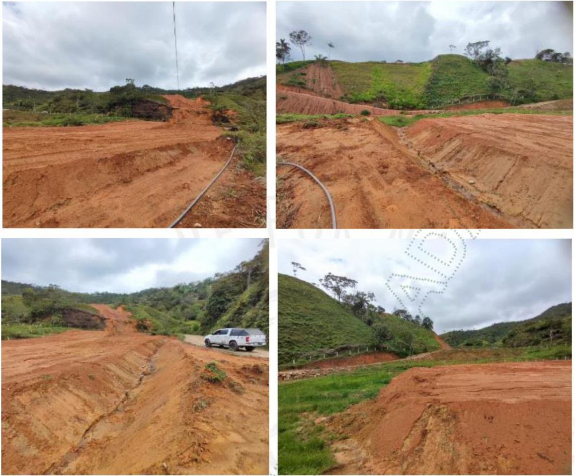
Foto 1. Ubicación de lleno sobre zona de empozamiento e inundación de las Q. Sin Nombre 1 y 2. Fuente: Cornare, 2024.
