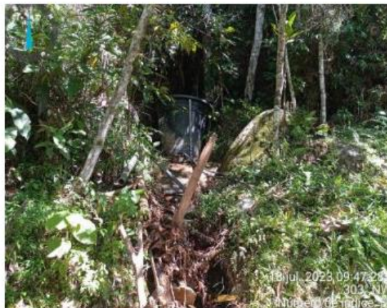
Foto 6. Instalación de tanque sin permiso de conceción de aguas. Fuente: Alcaldía del Municipio de San Roque, 2023.
