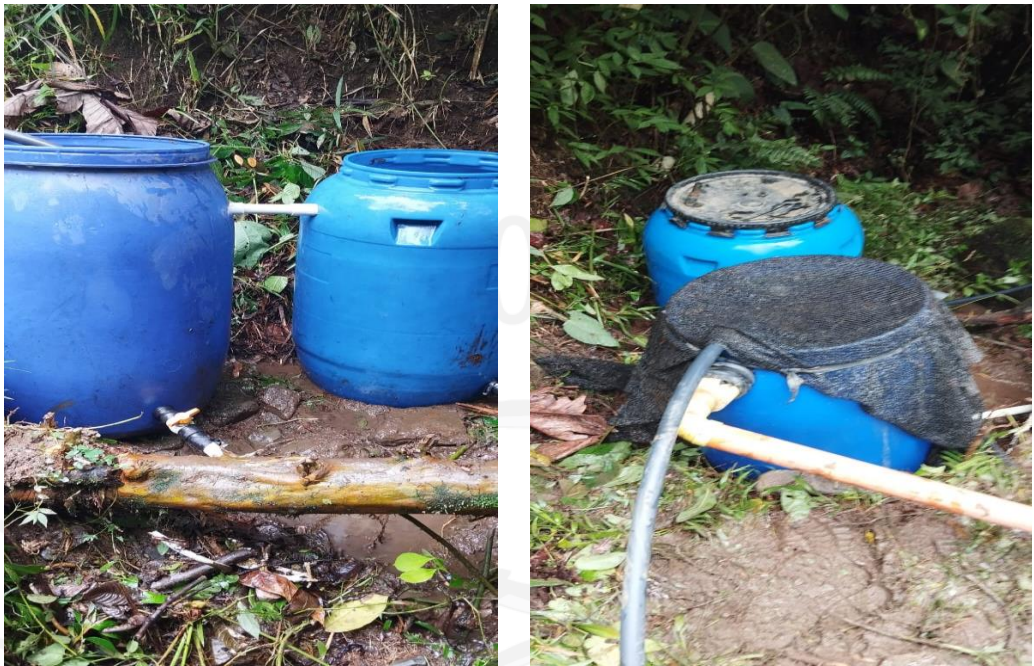
Obra de control de caudal implementada
