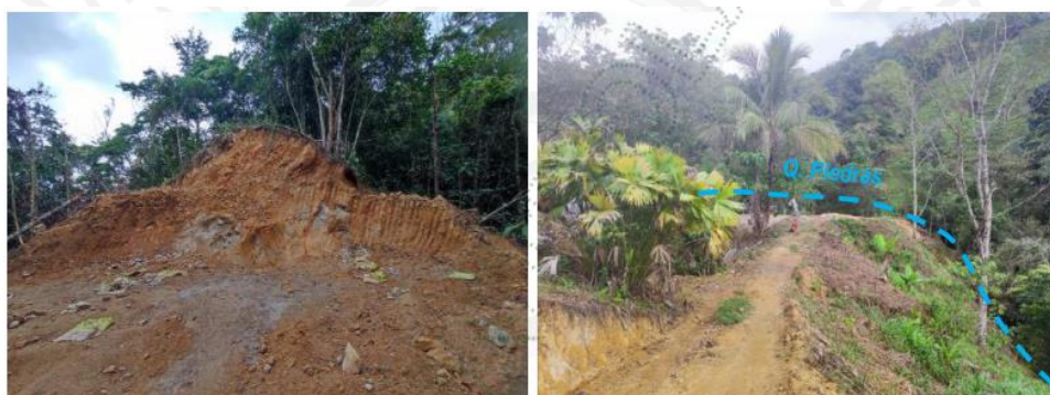
Foto 1. Movimiento de tierras. Fuente: Cornare, 2024.
