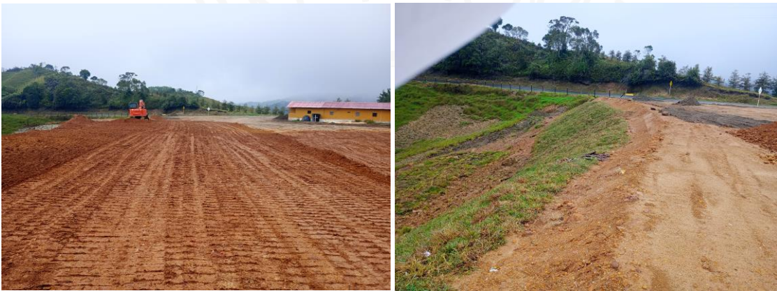
Imágenes 4 y 5 zona de deposito
