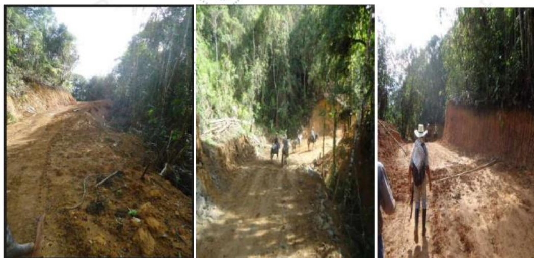
Ampliación de camino para adecuación de vía
