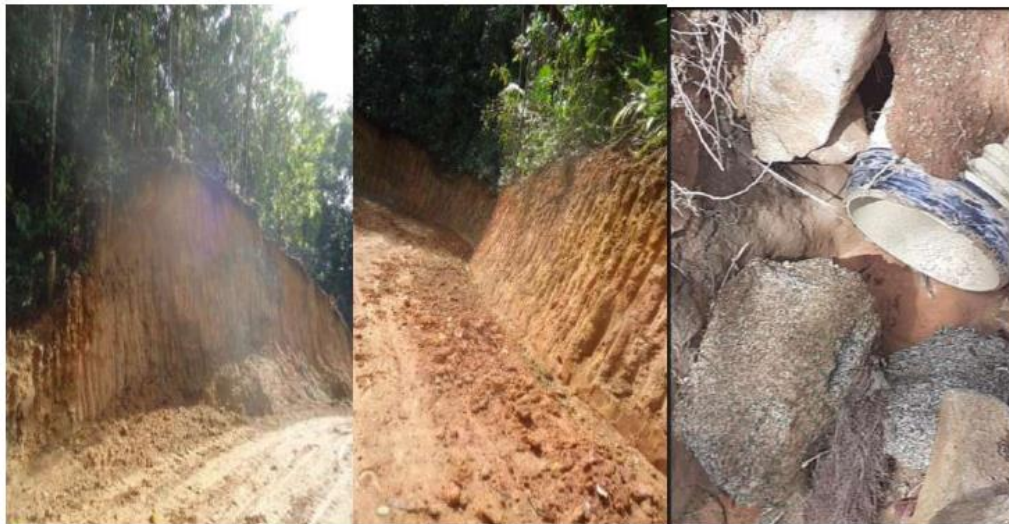
Implementación de cunetas y transversales
