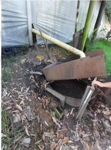
**Fotografía 3. Primera salida de ARnD hacia malla y tanque (tipo pretratamiento) y zona húmeda por salpicadura o posibles reboses**
