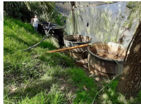
**Fotografía 4. Tanque tipo trampa grasas colmatado y descarga a tanques de almacenamiento y recirculación**
