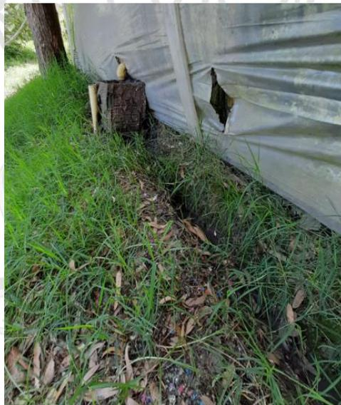
**Fotografía 5. Segunda salida con posible descarga a canal en tierra sin ninguna impermeabilización.**
