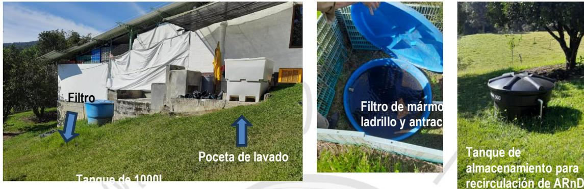
**Fotografía 1. Sistema de tratamiento de aguas Residuales no domésticas - Sistema de desactivación (filtración). Fuente: Cornare, 2024.**
