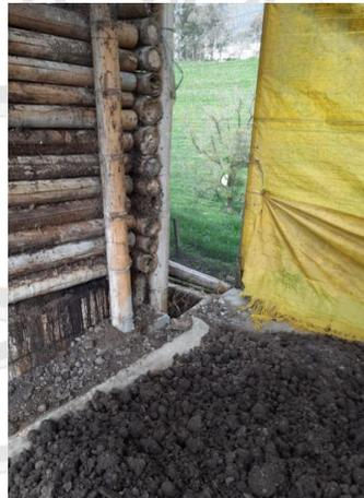
Manejo de lixiviados (condición mediante cuneta perimetral a caja de acumulación).
