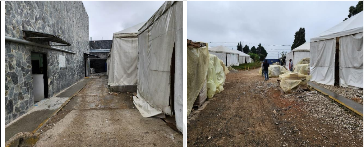
Instalaciones externas y zona de almacenaje
