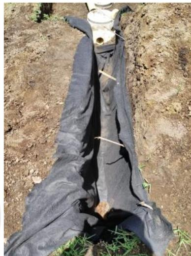
Descarga STARD Casa Principal – Zanjas de Infiltración
