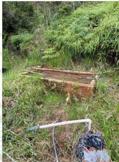
Imagen 4. Punto de captación
