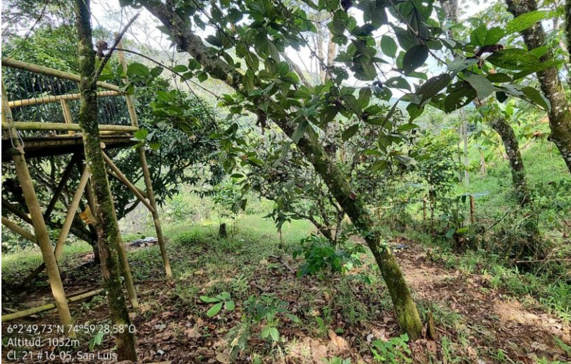
Figura 3. Inclinación respecto a la estructura de madera identificada
