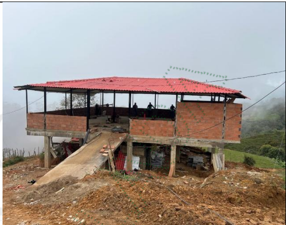
Figura 3. Estado de la vivienda
