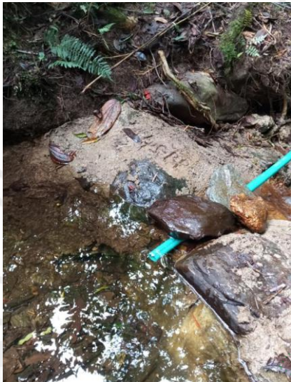
Imagen 1. Obra de captación
