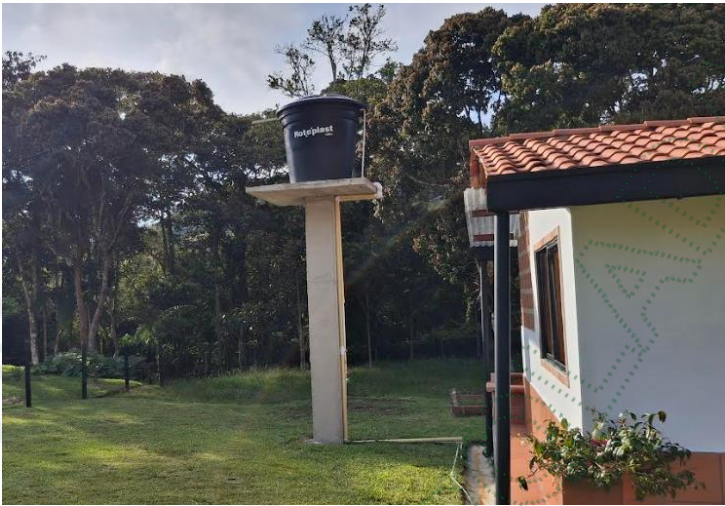
Imagen 3. Tanque de Almacenamiento
