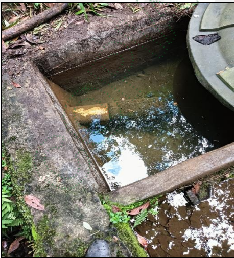
Imagen 1. Aranzalez, S.J. (2024). Obra de captación, Rionegro.
