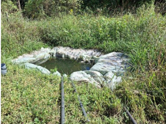
Imagen 2. Pozo de succión impermeabilizado
