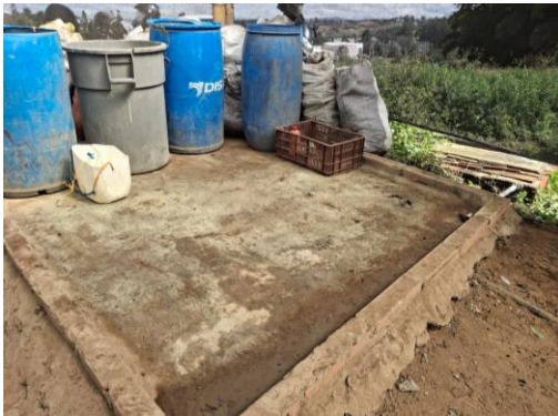
Imagen 4. Losa para preparación de fertilizantes
