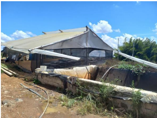
Imagen 3. Tanque de almacenamiento.
