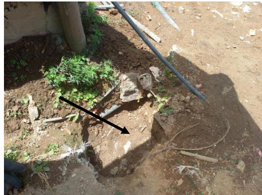
Imagen 4. Caja receptora de derrames - filtro
