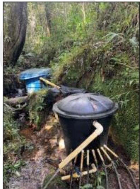
Figura 6. Captación y Tanque de distribución
