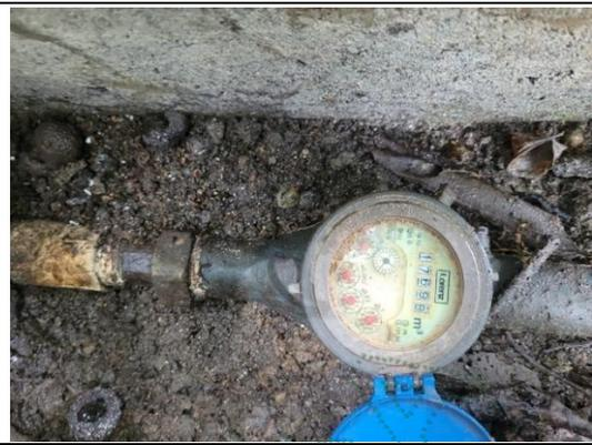
Figura 4. Macromedidor para control del caudal concesionado
