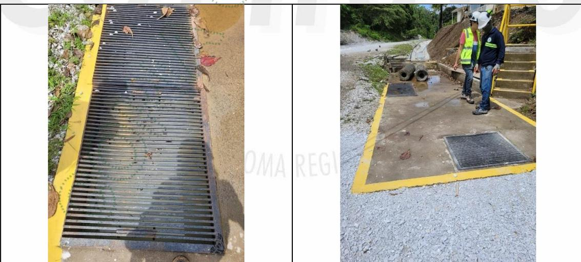
**Figura 10. Cárcamos y rejillas para retención de sólidos**
