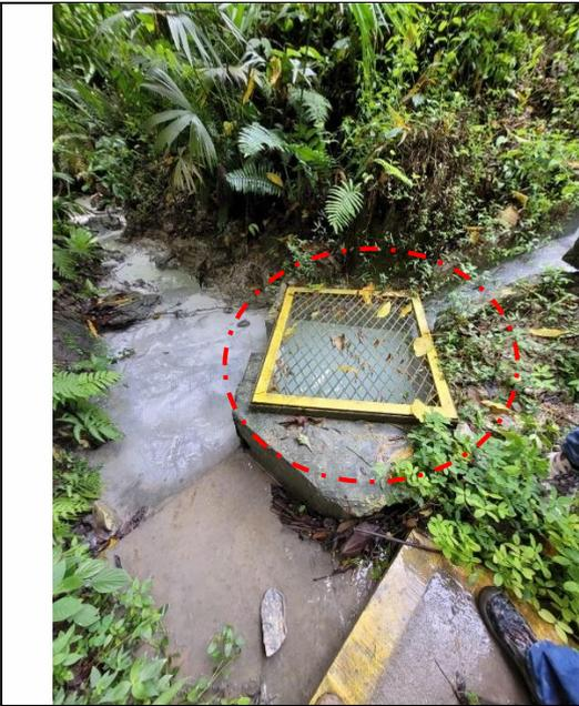
Figura 12. Segundo sedimentador implementado
