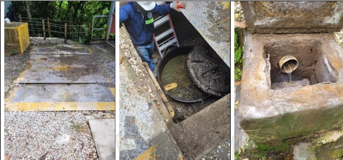
**Figura 7. Unidades de tratamiento primario y secundario Sedimentador (tanque séptico) y FAFA**
