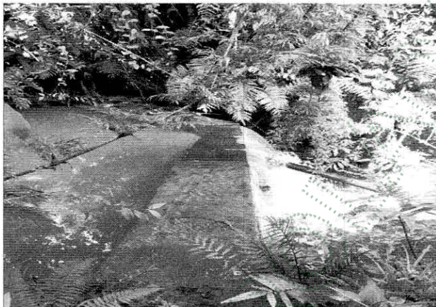
Obra de captación con toma de rejilla
