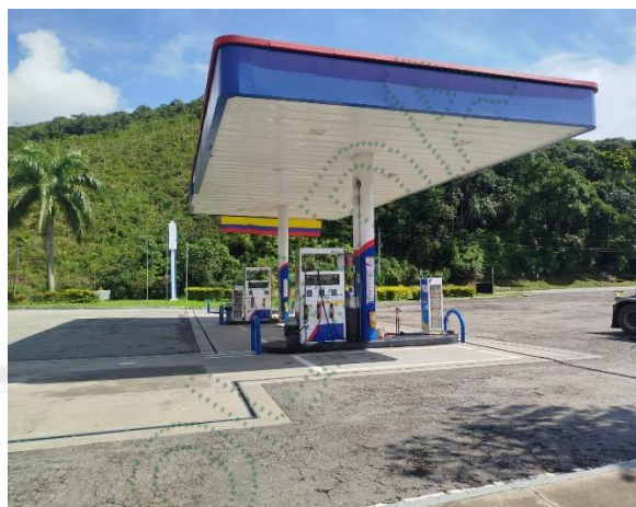
Figura 2. Estación de servicio Los Aragonés
