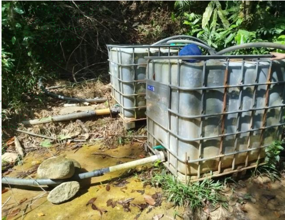
Figura 6. Tanques de almacenamiento existente
