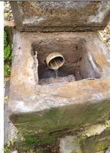
**Figura 9. Caja de inspección de salida previo al campo de infiltración**
