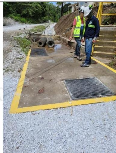
**Figura 11. Primer sedimentador implementado**
