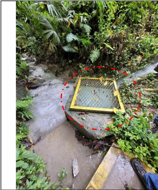
Figura 12. Segundo sedimentador implementado
