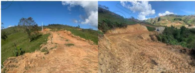
Figura 3. Apertura de vía
