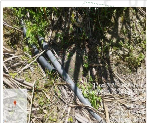
Imagen Nro.1: Estado actual de las tuberías del punto de captación
