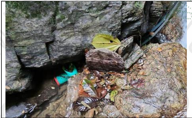
Imagen1. Captación del recurso hídrico con dos (2) mangueras de diámetro de ½” – Cornare 2024
