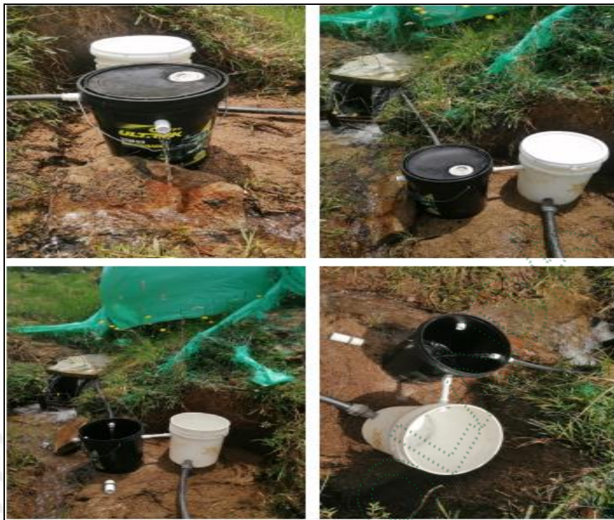
Ejemplo de obra control de caudal económica (diseño)
