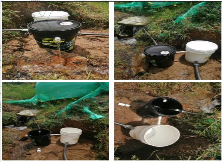
Ejemplo de obra control de caudal económica (diseño)
