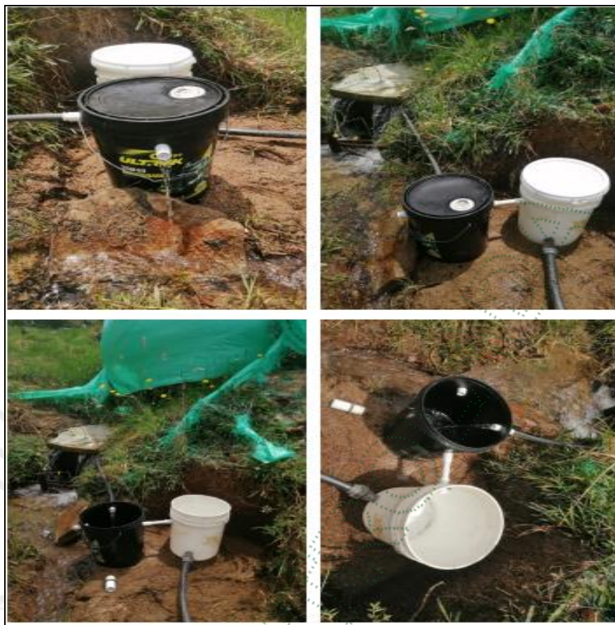
Ejemplo de obra control de caudal económica (diseño)
