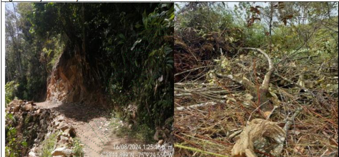
figura N°2 y N°3 Tala y socavación del terreno
