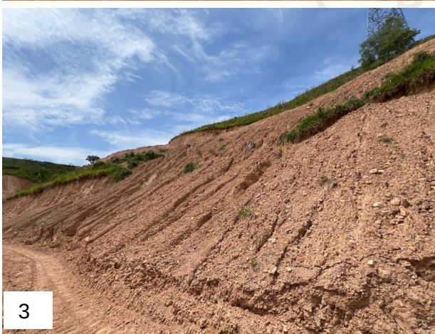
Foto1. Sección transversal de la vía interna, proyecto "Parcela La Riviera". Foto 2, 3 y 4. Surcos y cárcavas sobre los taludes generados por aguas de escorrentía. Fuente: Cornare 2024
