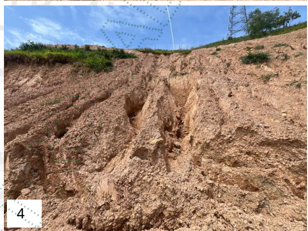
Foto1. Sección transversal de la vía interna, proyecto "Parcela La Riviera". Foto 2, 3 y 4. Surcos y cárcavas sobre los taludes generados por aguas de escorrentía. Fuente: Cornare 2024
