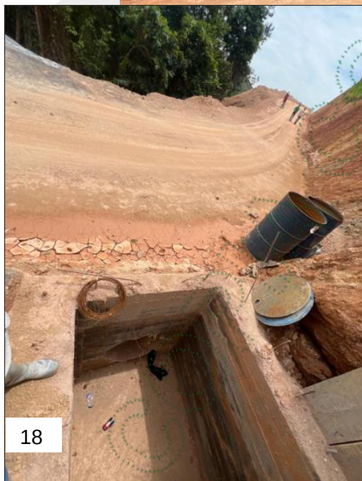
Foto 17, 18 y 19: Obras hidráulicas en construcción (dissipador de energía, encole y descole de obra transversal de la vía), que descarga sobre la fuente hídrica 2.
