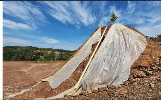
**Imagen11.** Drenaje con tubería y plástico. Fuente: Cornare2024
