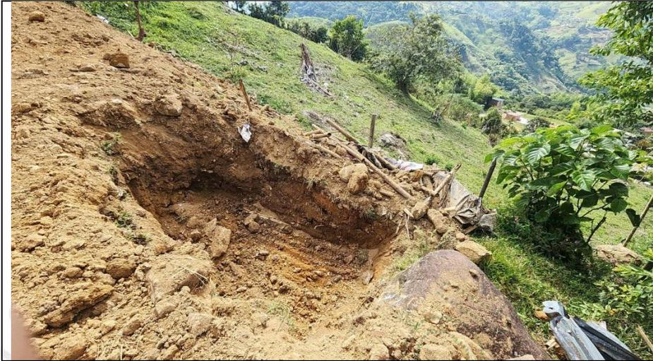
**Imagen 7.** Excavación para la supuesta construcción de sistema séptico.
