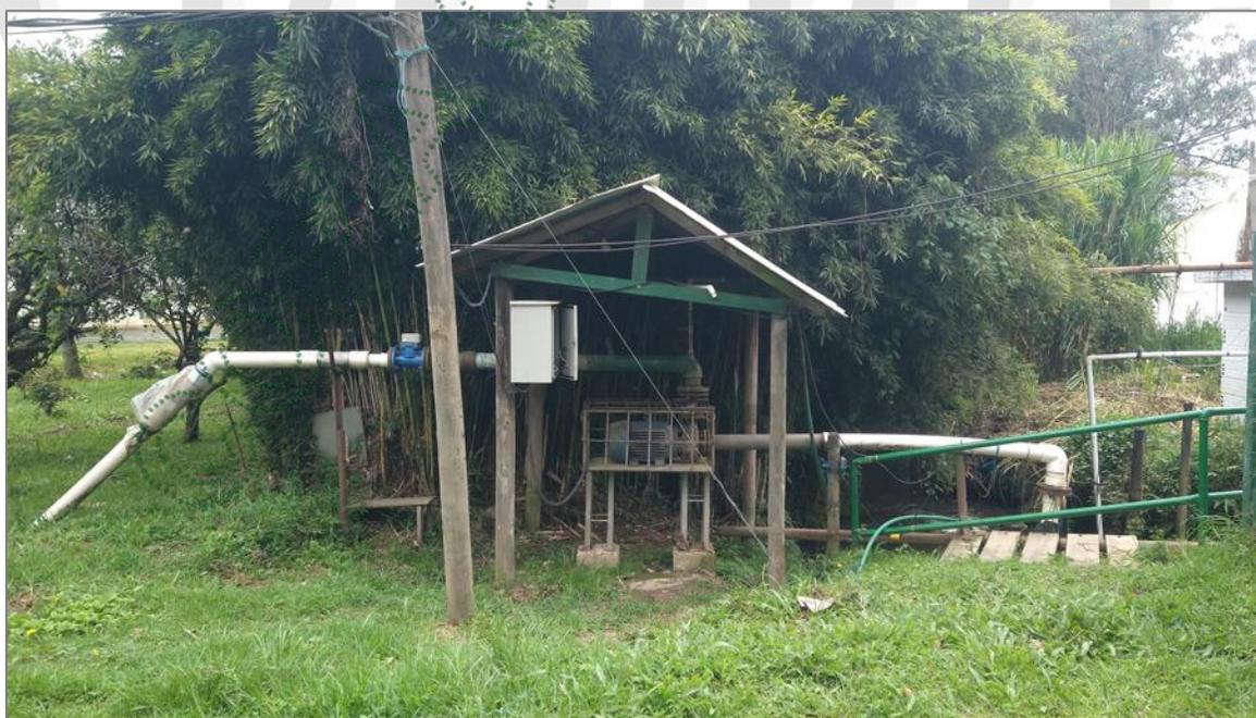
Foto 3. Sistema de captación actual de la fuente Q. Manzanares (Cámara de bombeo)
