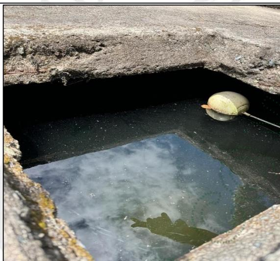
Imagen 3. Aranzalez, S.J. (2024). Dispositivo de control de flujo y tanque de almacenamiento predio 020-16473, Guarne.
