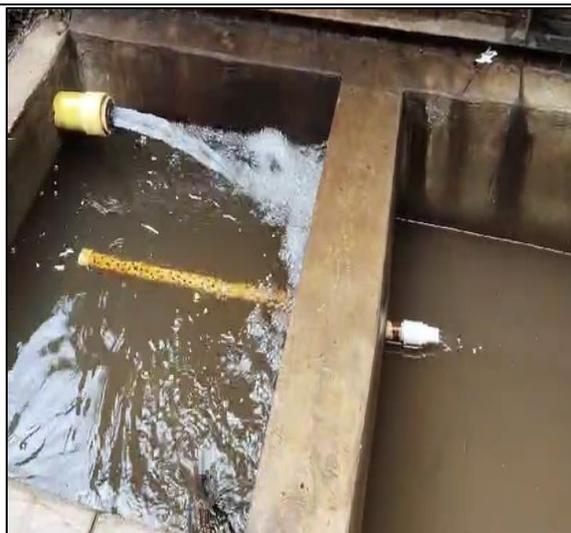
Imagen 1. Aranzalez, S.J. (2024). Obra de derivación y control de caudal, Guarne.
