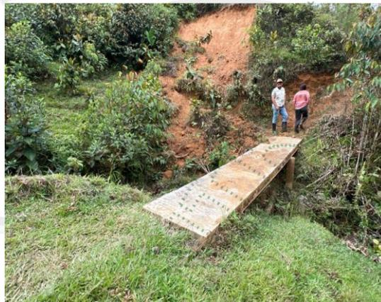
Foto 11. Placa en concreto sobre fuente hídrica
