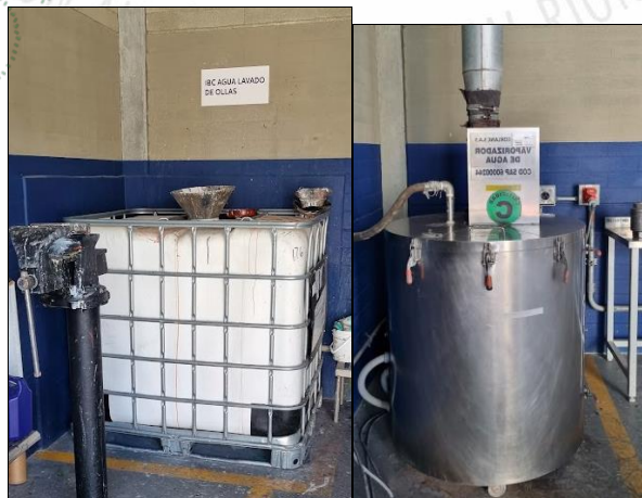
Imagen 6. Proceso evaporación agua de lavado de ollas con pinturas-CORLANC
