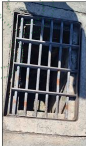
Imagen 8. Conducción aguas subsuperficial
