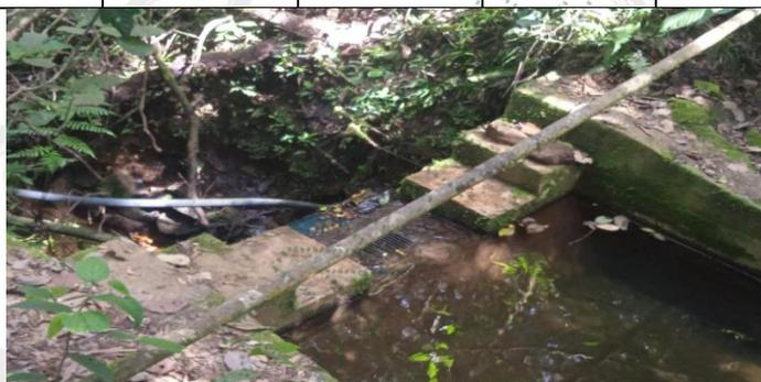
La captación se realiza mediante un represamiento de mampostería. El recurso hídrico es conducido por gravedad, a través de tubería de 2", a un tanque de almacenamiento. Desde allí el agua es devuelta a la fuente, nuevamente, a través de un tubo de salida de una caja de mampostería. El permiso para captar desde la "FSN4" está vencido.
