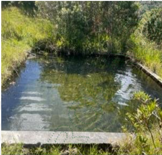
Imagen 4, Tanque de almacenamiento y distribución
