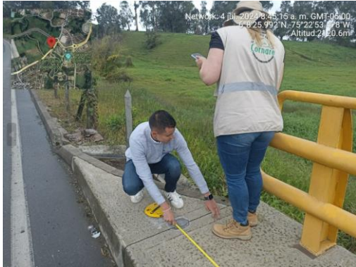
Fotografía N° 1. Verificación de longitud del Puente Vehicular 1
