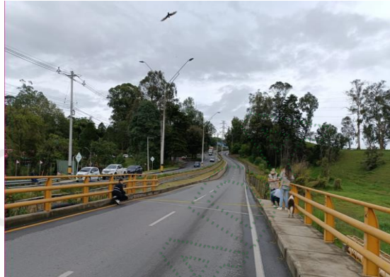
Fotografía N° 2. Verificación de ancho Puente Vehicular 1
