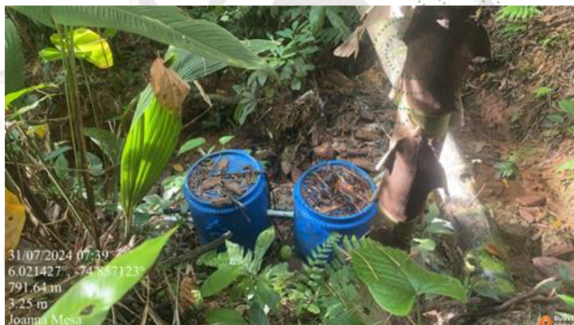
Obra de captación y control de pequeños caudales implementada
