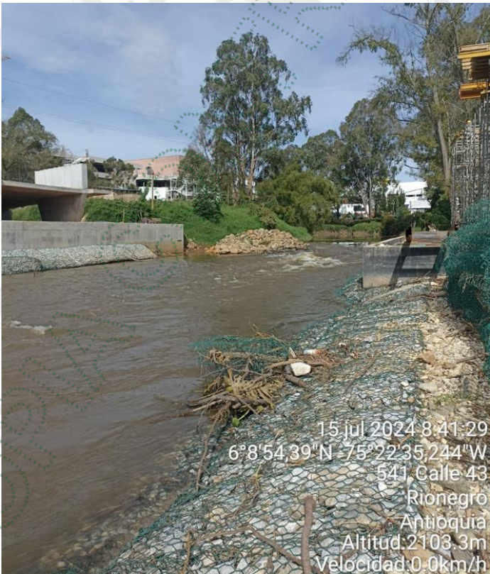
Ilustración N° 1. Situación actual en el sitio de implementación de ataguía (Norte y Sur)
