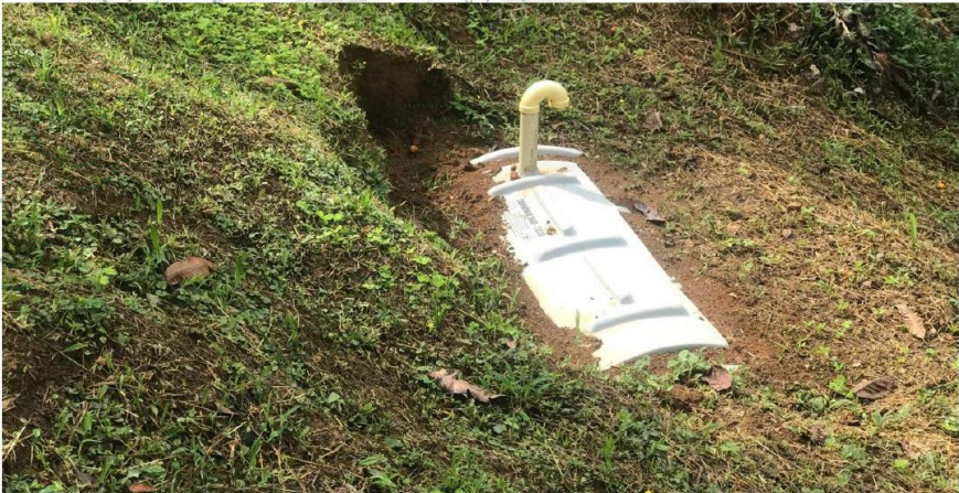
Figura 5. Instalación del sistema séptico
