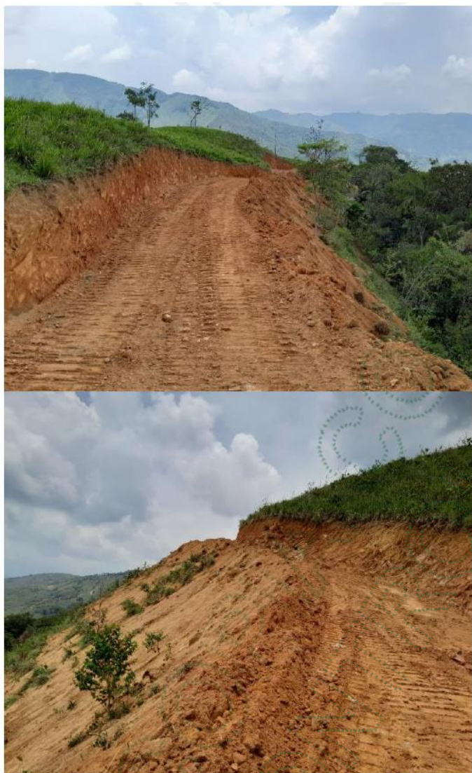
Imágenes de la vía aperturada y el deposito de tierras sobre las laderas
