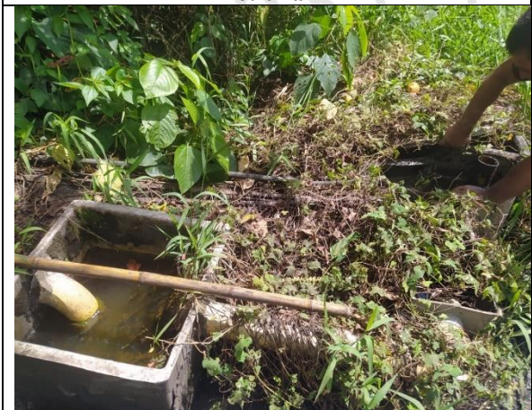
Figura 20. Trampa de grasas en desuso en el lavadero del señor Jairo Piedrahita.
